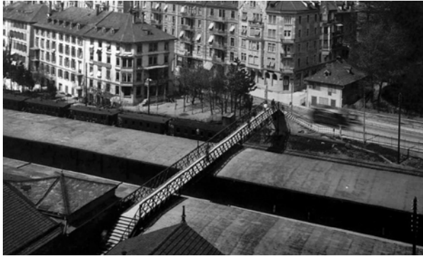
Alte Passerelle am Hauptbahnhof St.Gallen von 1880 bis 1907
